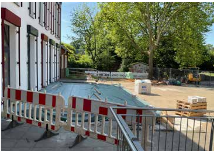
Die Außentreppen wurden begradigt, damit der Ausbau der Mensa weiter gehen kann.
