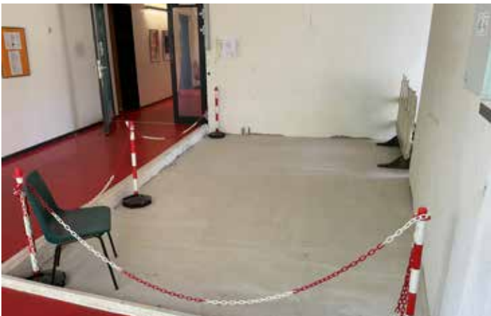
Der „Schacht“ mit Blick auf das Erdgeschoss ist mit einer Decke eingezogen worden. Hier befindet sich in Zukunft die Erweiterung des Bewegungsraums.
