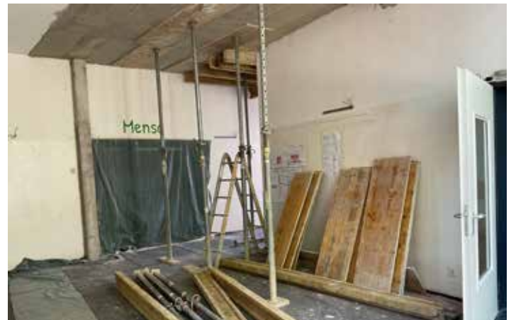
Noch muss der Boden des Bewegungsraums abgestützt werden. So ist auch der Eingang der Mensa gesperrt. Die Kinder nutzen den Eingang vom Schulhof aus.
